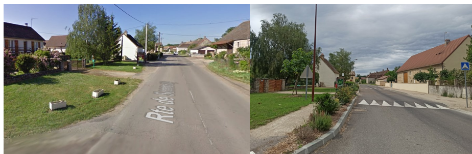
Avant les travaux au hameau de Nully
